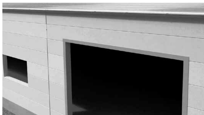
Omkring brede åbninger anbefales brug af en stålramme
