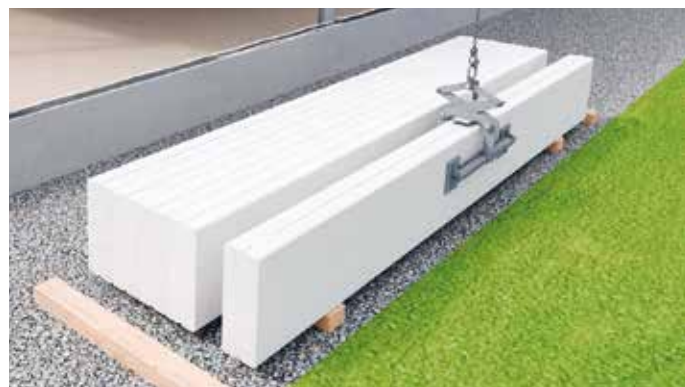
Løftemidlet skal være midt på elementet
