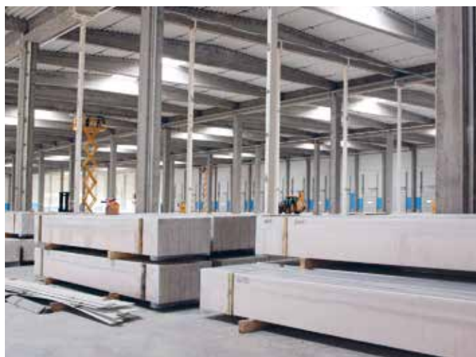
Oplagring på betongulv
