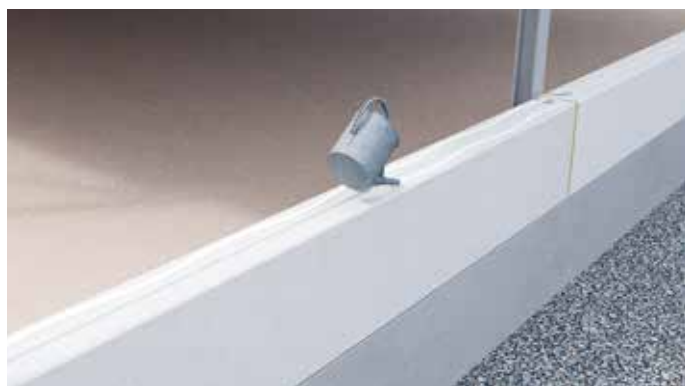
Det er bekvemt at dosere limblandingen med en vandkande
