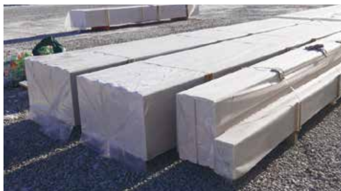
Elementer leveret til byggepladsen skal være beskyttet mod nedbør
