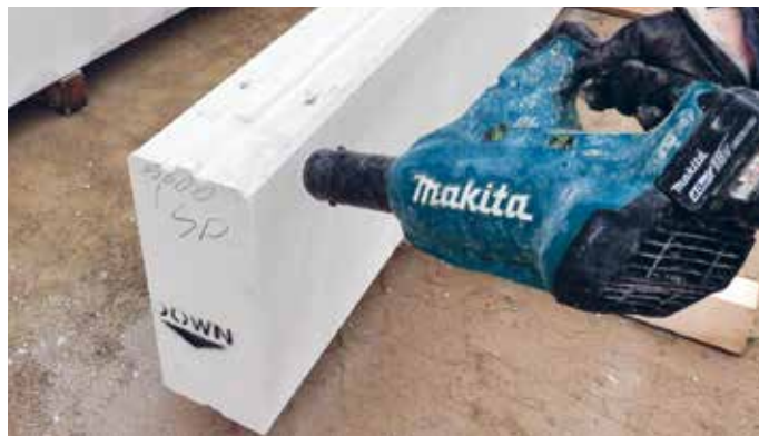
Efter fræsning renses elementets overflade for løst smuld
