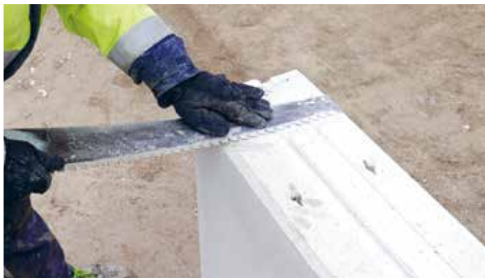
Udfræsning af en fordybning til fastgørelsesanker
