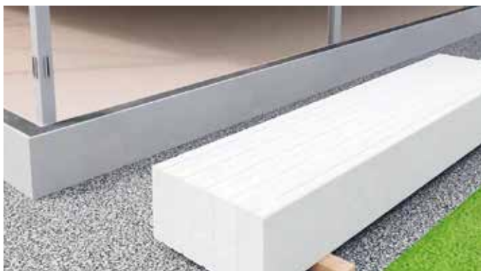
På fundamentet skal der anbringes en fugtspærrestrimmel
