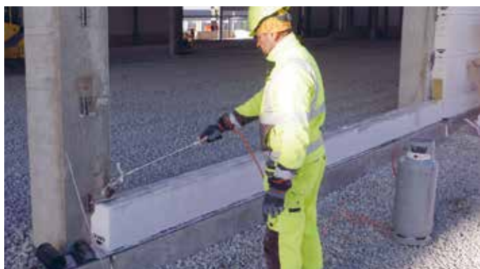
En rimbelagt overflade skal opvarmes inden påføring af lim.
